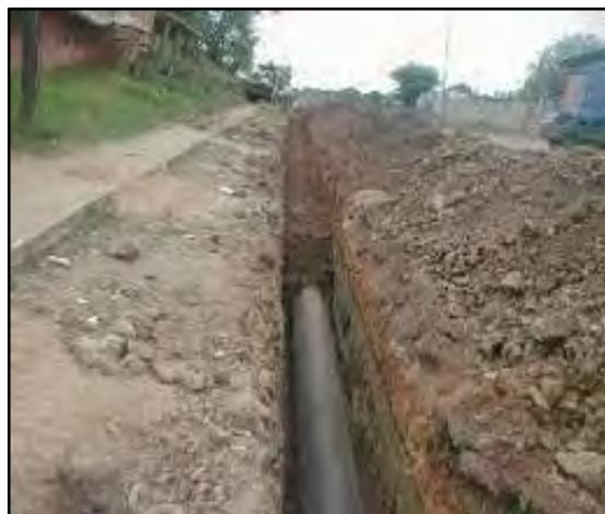
*Figura N° 3: Excavación a cielo abierto.*
